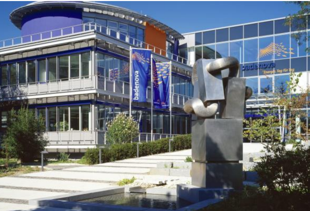
Badenova errichtet den ersten Schnellladepark Freiburgs. (Foto: Badenova)
